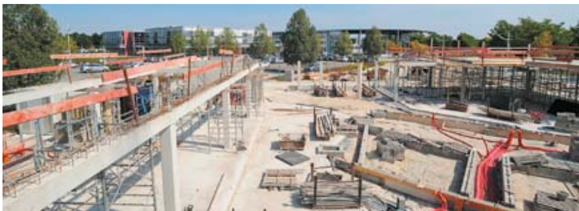
CHANTIER EPF (TROYES-ROSIÈRES). Le Conseil général a réalisé 50 % du gros œuvre du bâtiment de cette école d'ingénieurs.
